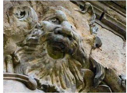
Détail du fronton de l'aile gauche du château de Saint-Cloud
